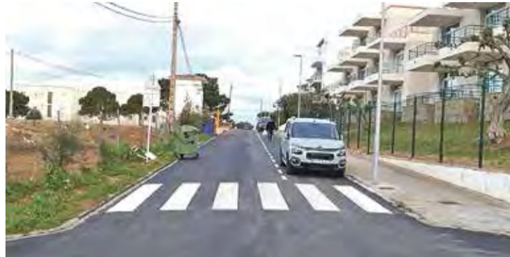
PINTURA VIÀRIA. És el que s'està fent aquests dies
