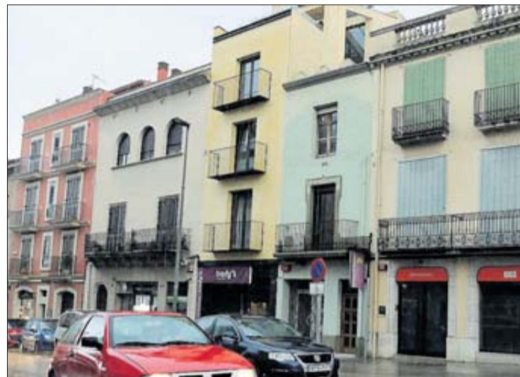
Al centre, el bloc de tres pisos on es feien les obres. CONXI MOLONS
