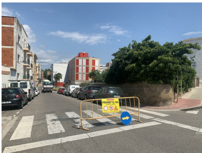
S'inicien les obres d'ampliació de voreres d'un tram del carrer
