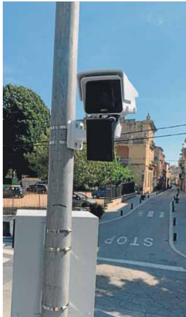
Una de les càmeres de vigilància que s'estan instal·lant a Santa Coloma de Farners ■ AJ. DE SANTA COLOMA DE FARNERS
