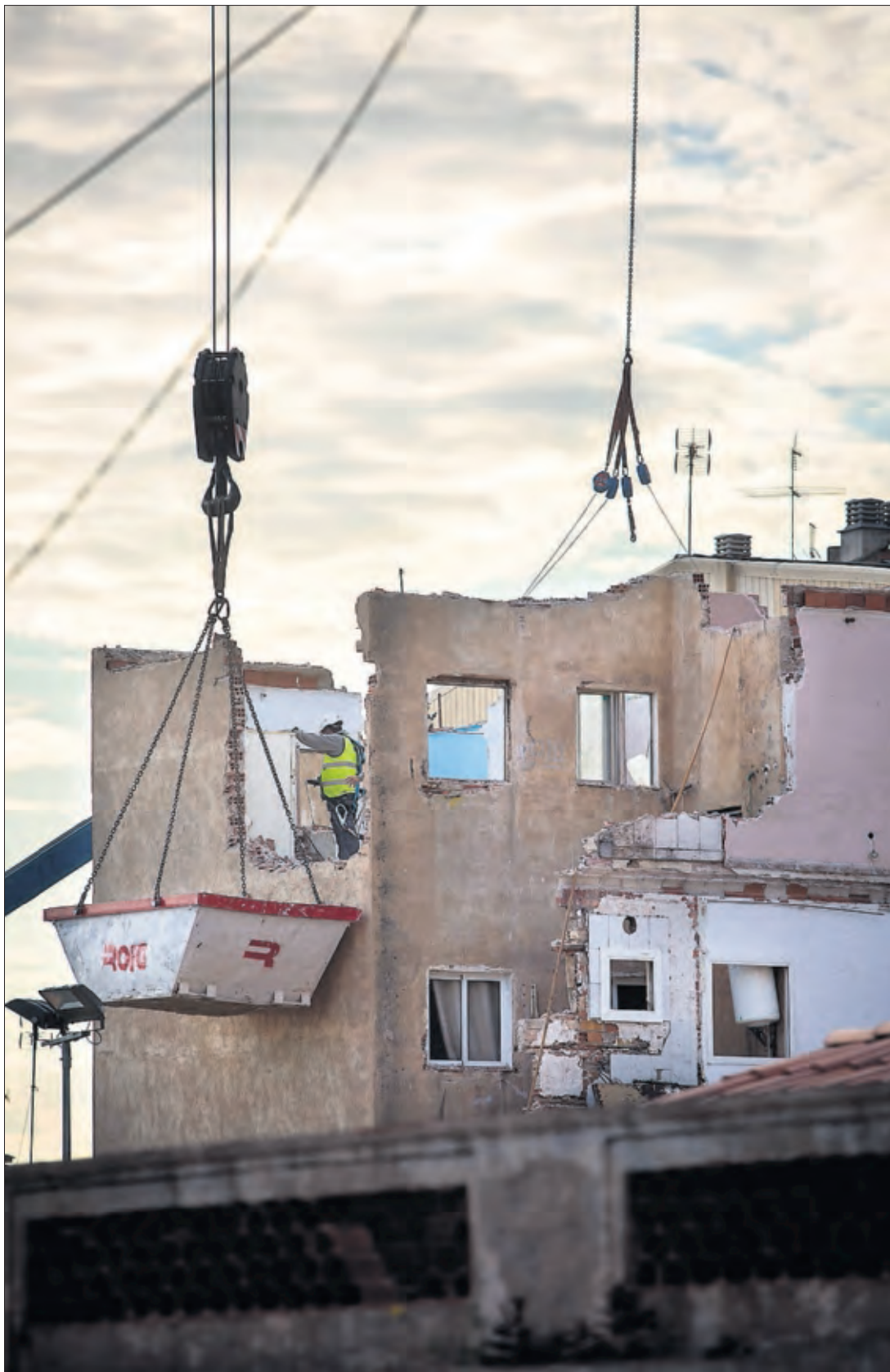
Un operario realiza tareas de derribo en el edificio afectado en Badalona. / MASSIMILIANO MINOCRI
