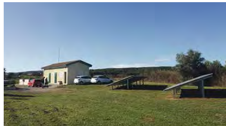
PIONERA. Són 36 panells amb una potència instal·lada de 10 kW
