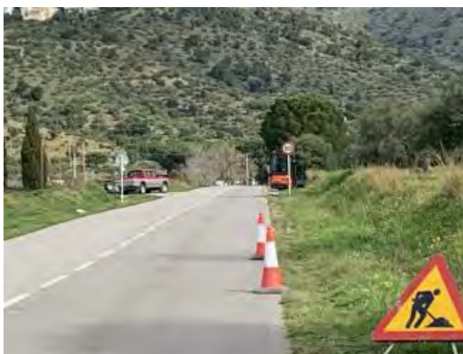
Els treballs a la carretera de les Arenes EMPORDA.INFO
