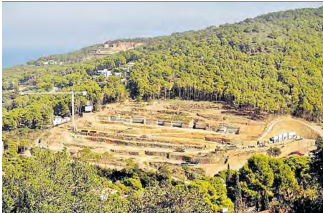
Les obres de construcció de 52 habitatges a sa Riera, zona que no ha quedat protegida. DIARI DE GIRONA
