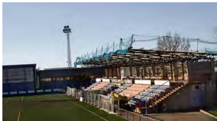
ESTADI MUNICIPAL. La coberta retirada era de fibrociment i ara serà de xapa
