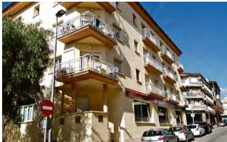
CARRER ARQUITECTE GAUDÍ. S'han instal·lat llums led de 60 wats
