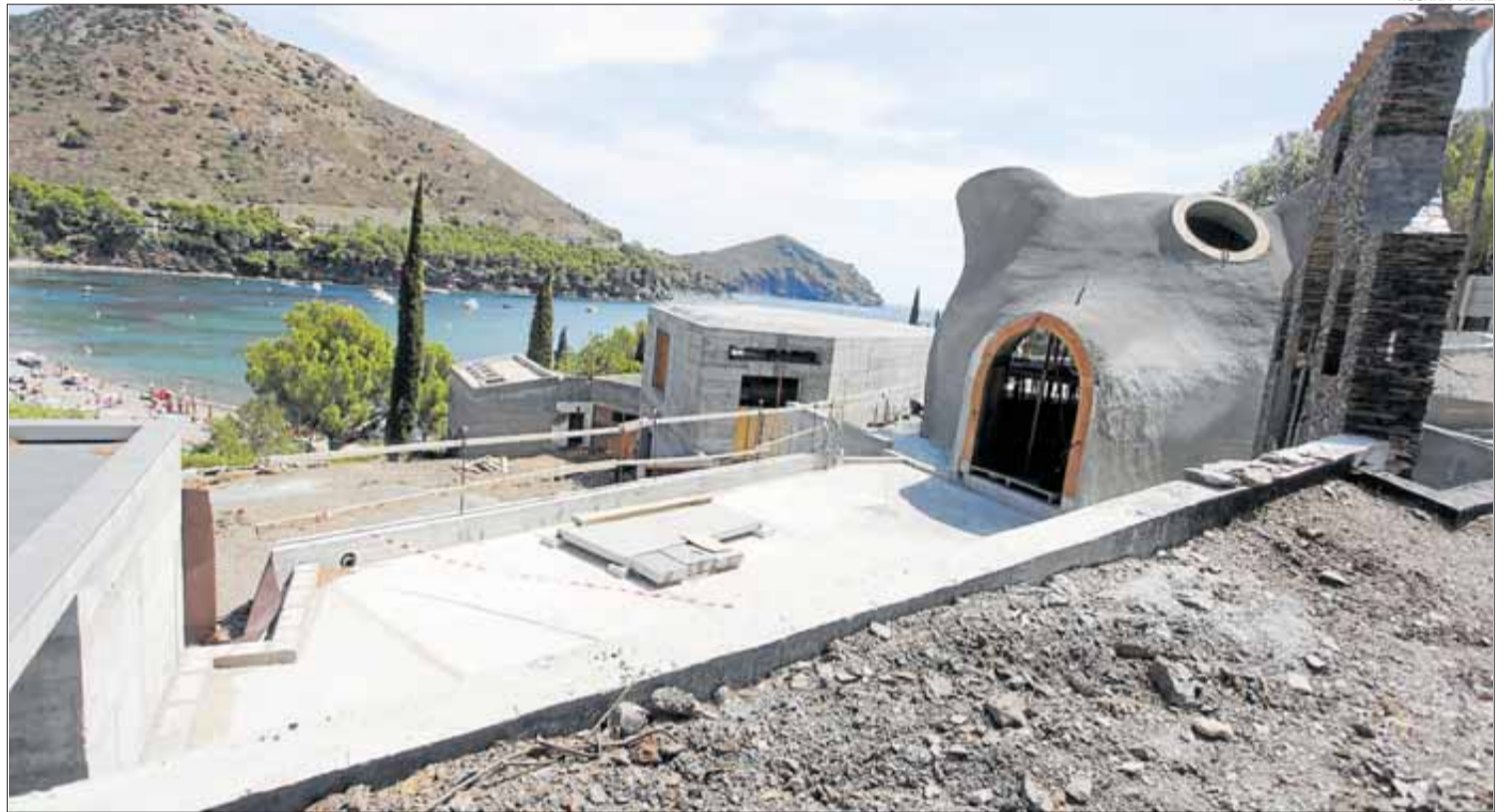
Vista de l'estat actual en què es troben les obres.
