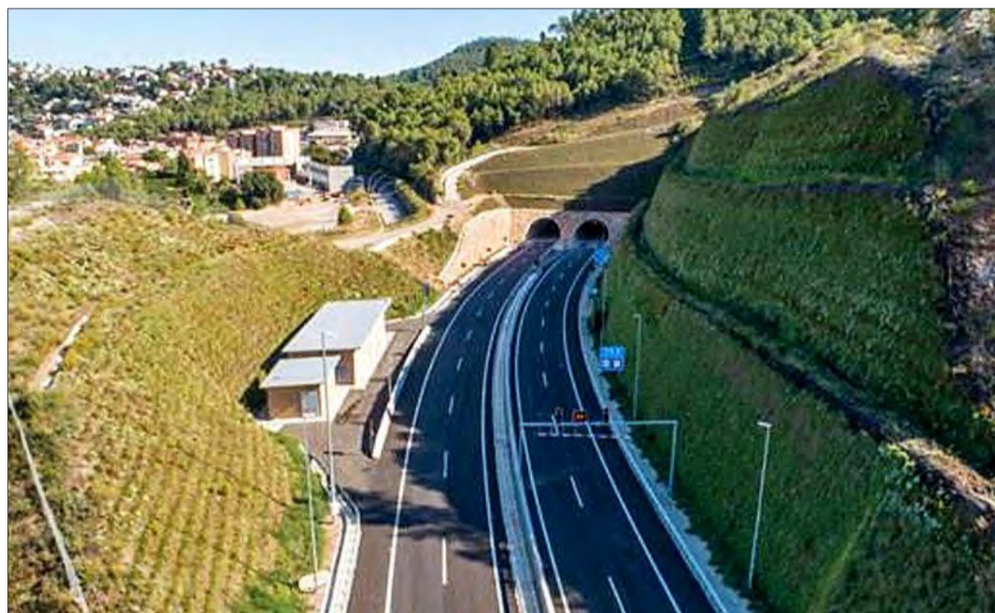
La variante de Vallirana entra hoy en servicio después de dos décadas de espera. E. M.
