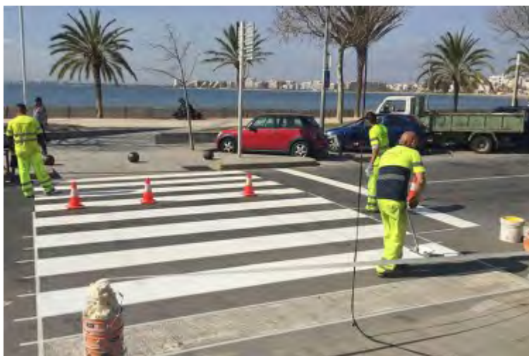
Operaris pintant la senyalització horitzontal de l'Avinguda de Rhode
