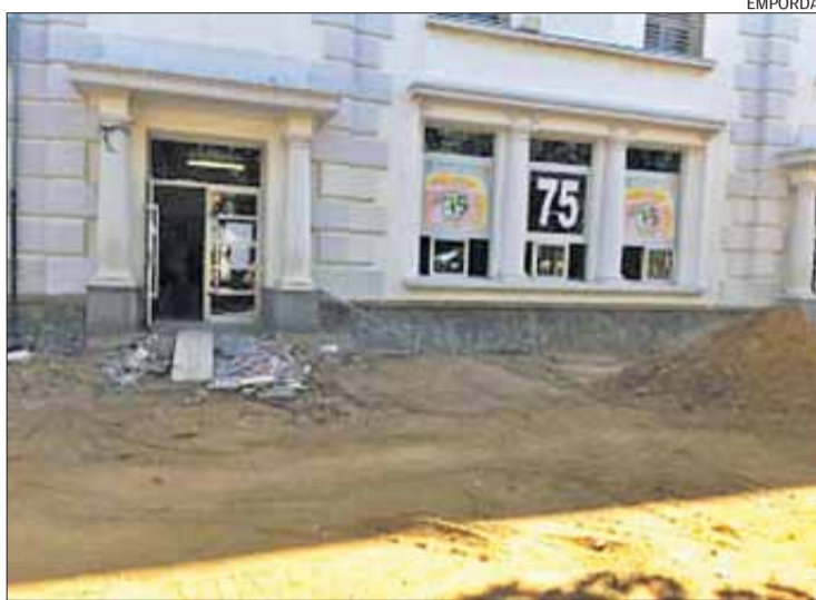
Les obres s'enllestiran de cara a l'inici de curs.
