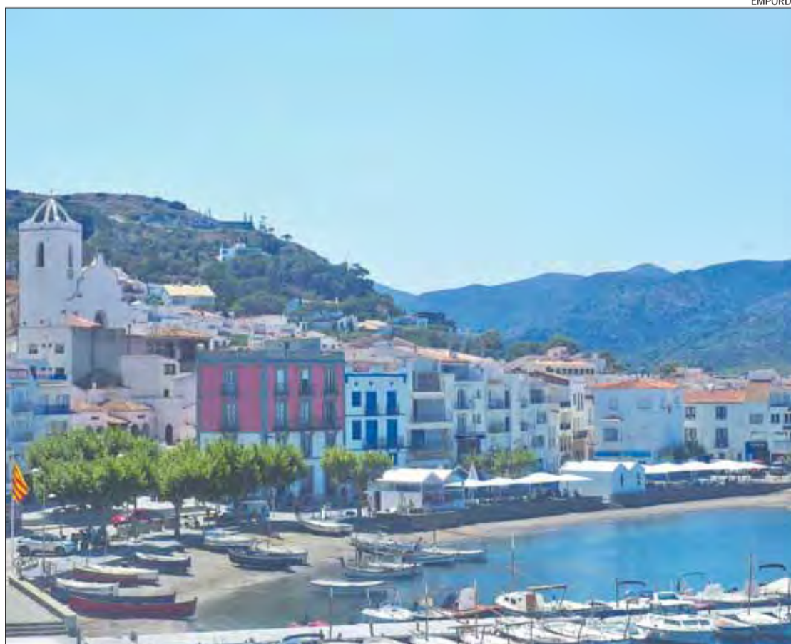
L'actuació ha reordenat l'espai i ha suprimit barreres arquitectòniques.
