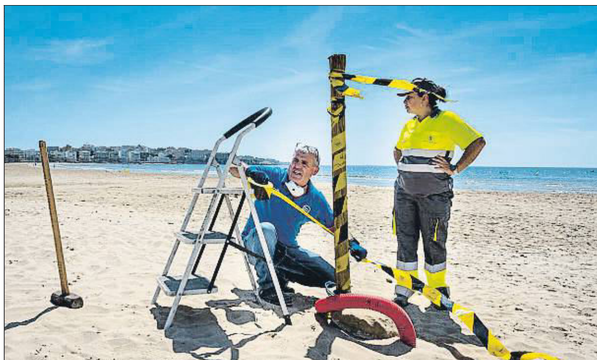
Diversos operaris van iniciar ahir la instal·lació d'un xiringuito en una de les platges de Salou
