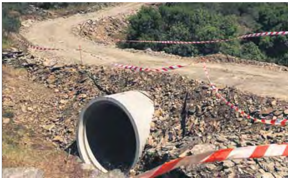
Alguns dels treballs d'obertura de vials a Sa Guarda ■ EPA
