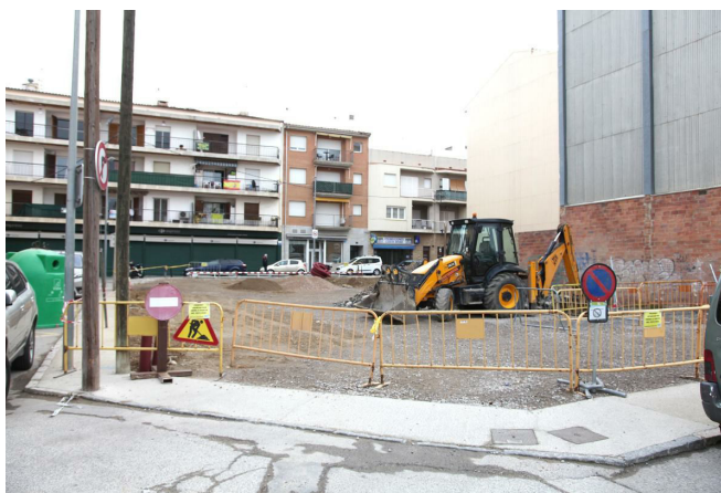
Obres que es podran fer fins al 24 de juliol GERARD BLANCHÉ
