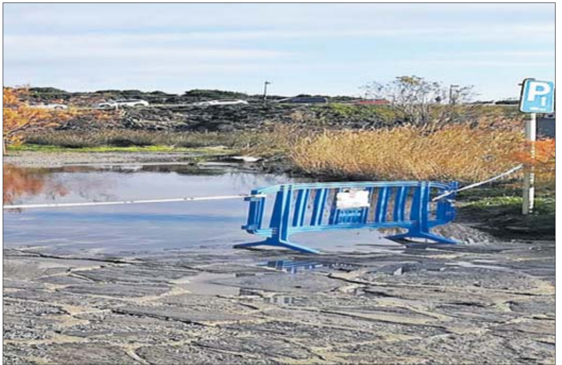
La zona amb les tanques que restringeixen el trànsit per l'acumulació d'aigua i el desnivell. AJ. DE CADAQUÉS
