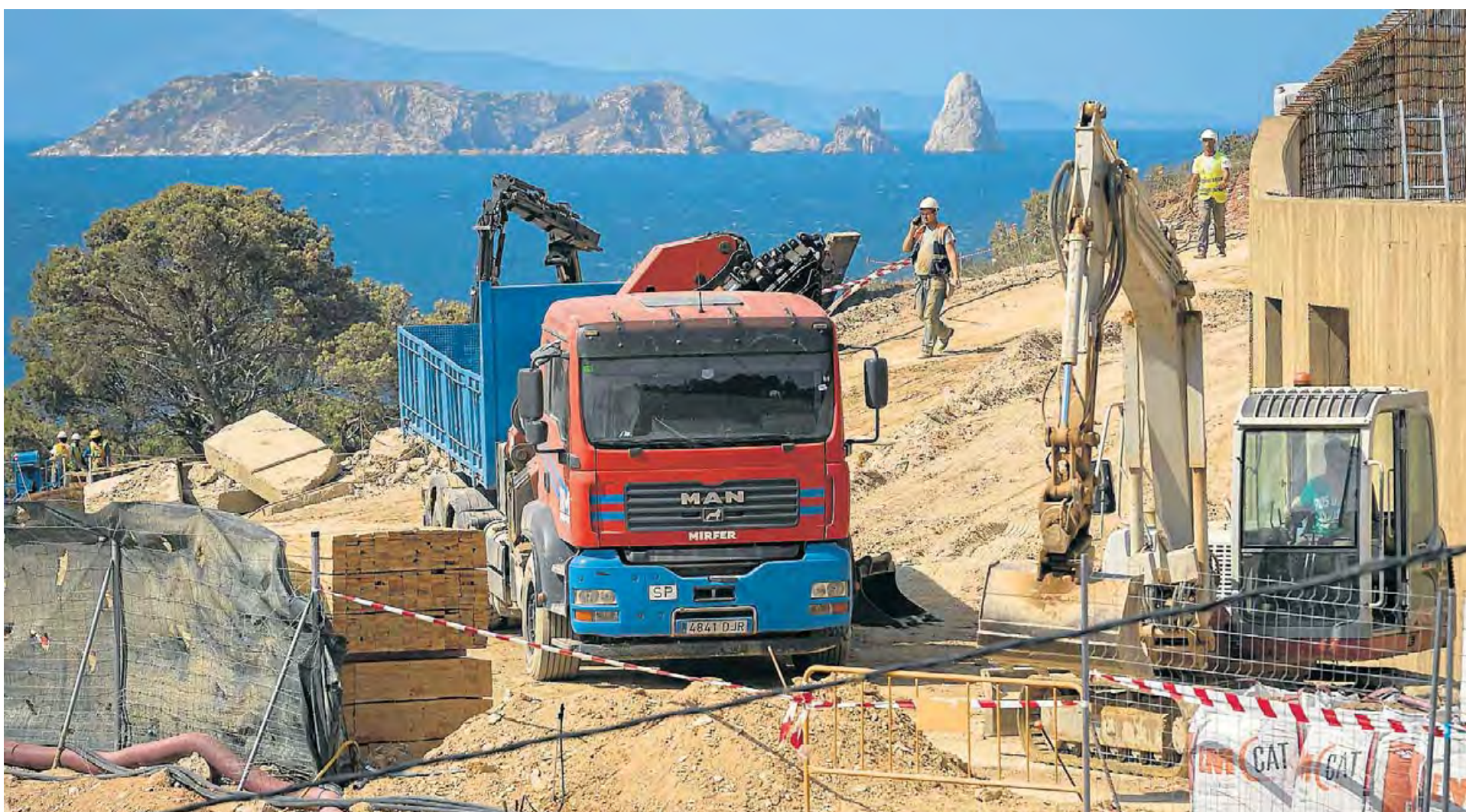
Els treballs de construcció a la cala de Sa Riera, a Begur, amb les illes Medes al fons. DAVID BORRAT
