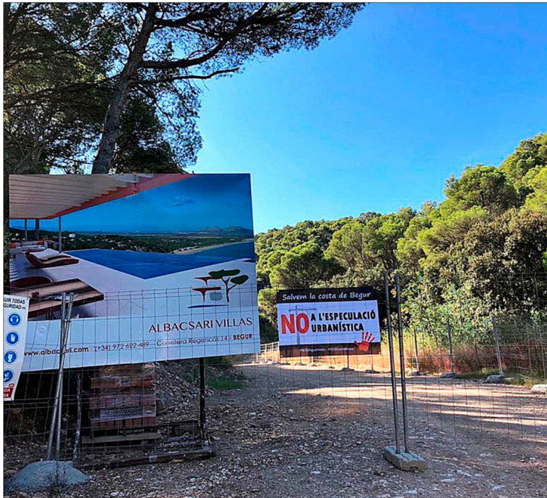
Imagen de la construcción de una urbanización en la zona de Begur. SALVEMAIGUAFREDA
