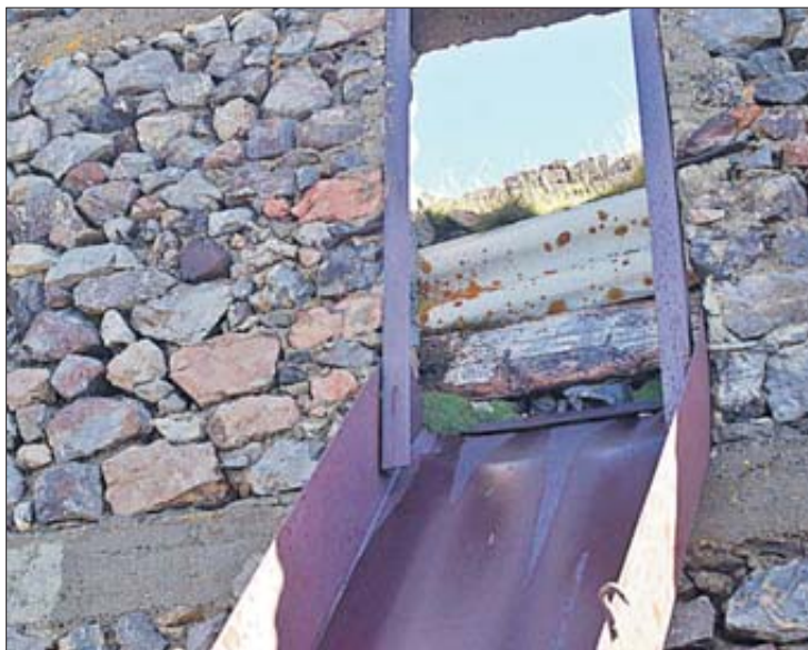
L'edifici del Carregador que servia per transportar el mineral. M. SPA
