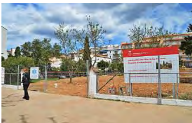
Estat de les obres vistes des de l'entrada principal de l'avinguda de Rhode. SANTI COLL
