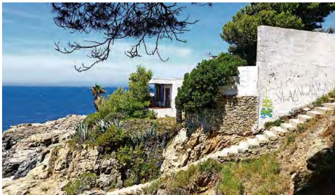
ESTAT ACTUAL. El deteriorament exterior de l'edifici és foça evident només amb un cop d'ull
