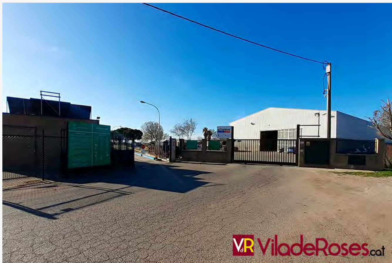
Entrada de la deixalleria municipal de Roses
