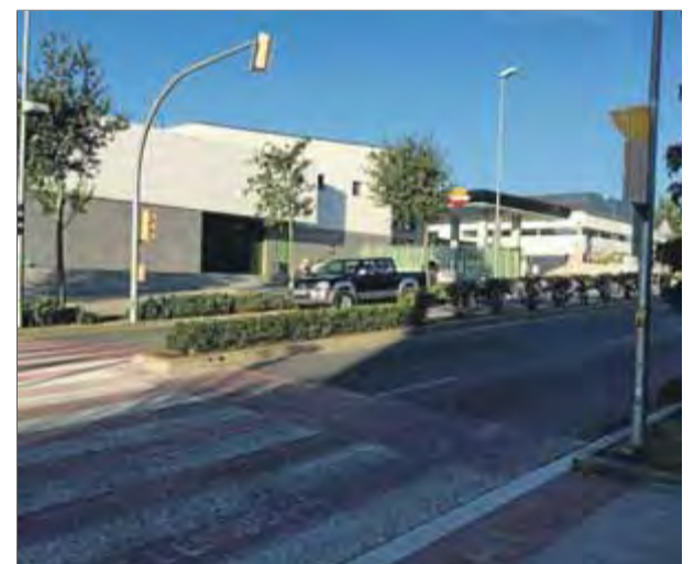
El nou semàfor instal·lat a l'avinguda Espanya, entre l'escola Carrilet i la zona de supermercats ■ AJ. PALAFRUGELL
