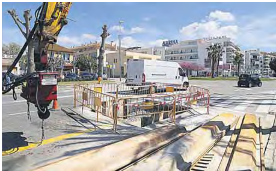
Obres al municipi de Roses, en una imatge recent ■ MANEL LLADÓ
