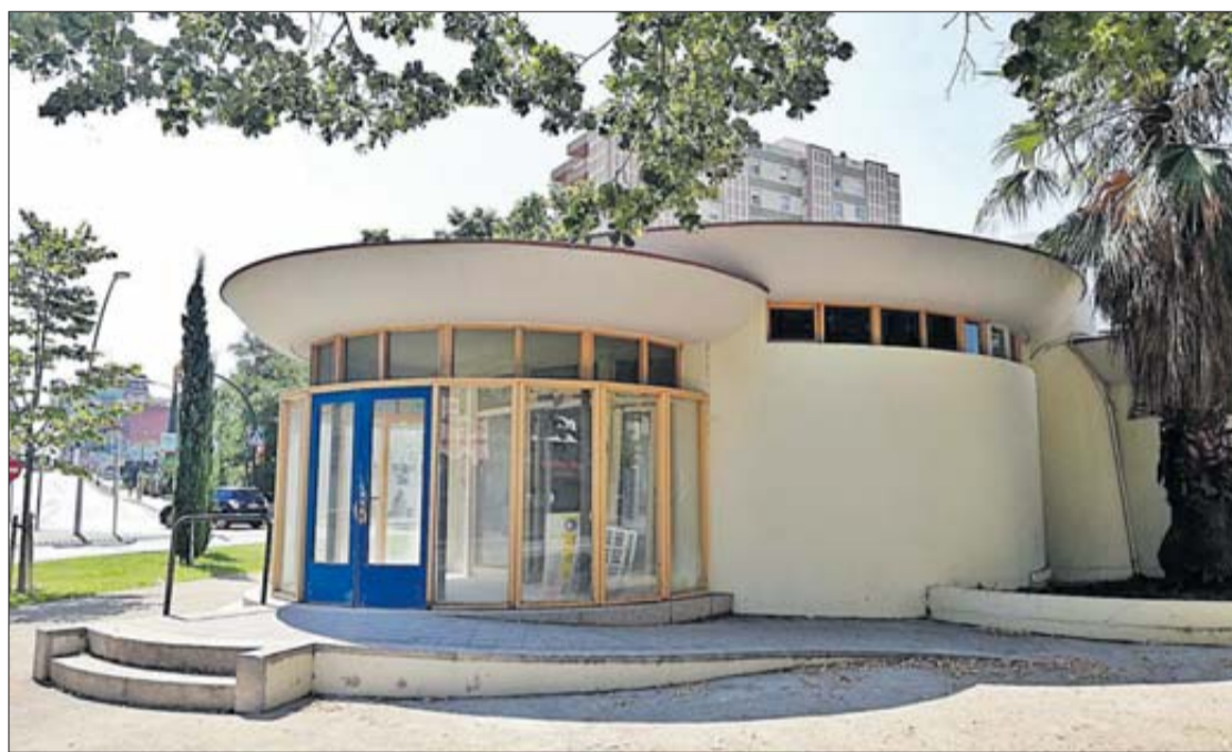
L'edifici a l'interior del giratori de la plaça del Sol. ANNA FONT
