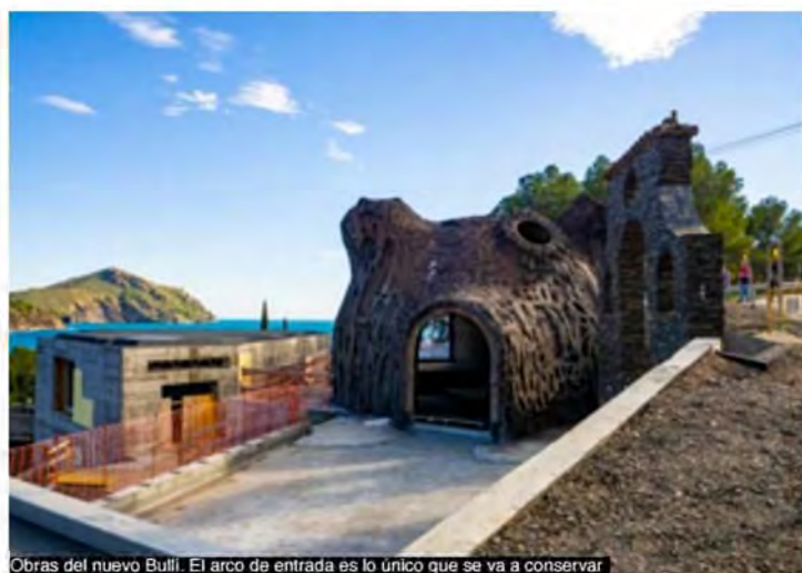
Obras del nuevo Bulli. El arco de entrada es lo único que se va a conservar
