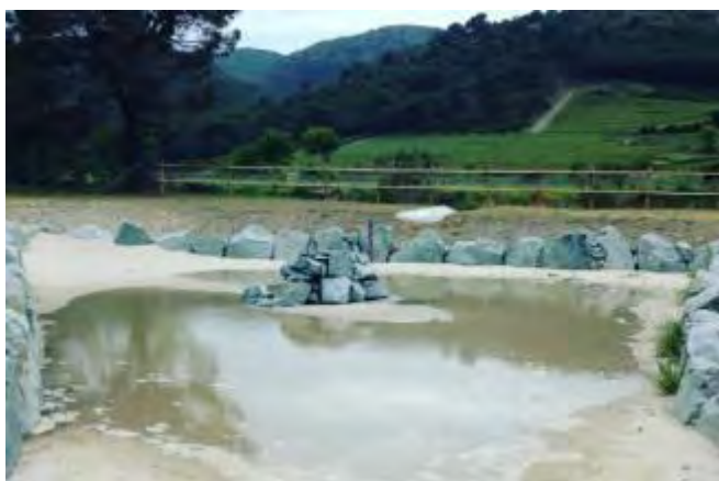
Basses de recàrrega de l'aquífer del Port de la Selva, ubicat a la comarca de l'Alt Empordà. aca
