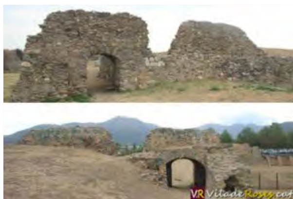
Aquest mur amb la seva petita porta de la Ciutadella de Roses, vista de les seves dues cares, està inclosa en aquest nou projecte de conservació, manteniment i restauració
