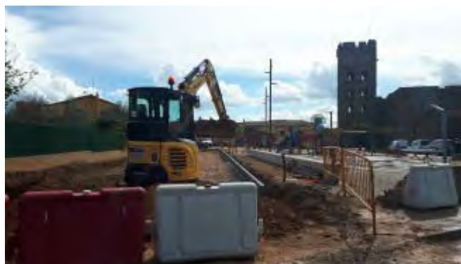
Les obres a Sant Miquel de Fluvià EMPORDA.INFO
