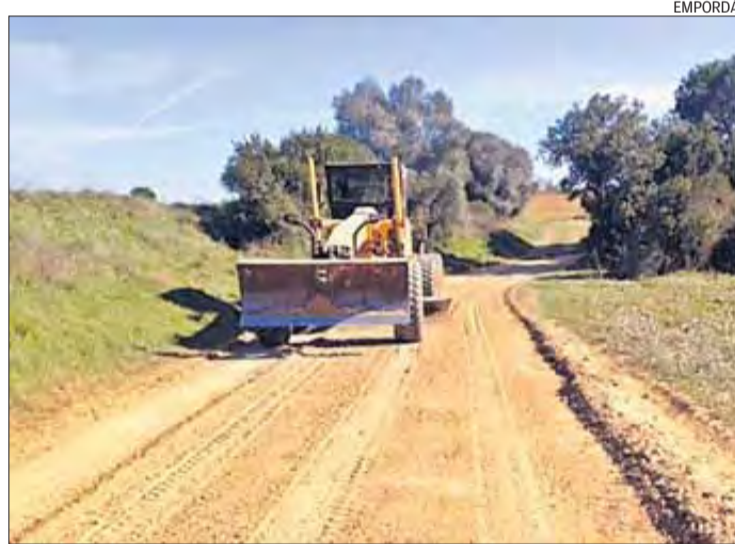
Els treballs d'arranjament dels camins rurals.
