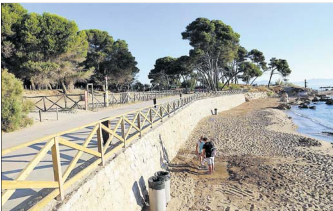
El tram de passeig després de les obres de reparació. BASILI GIRONÈS
