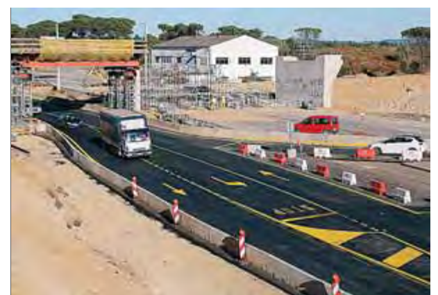
L'encreuament provisional de l'N-II a Caldes, amb la illeta per girar al mig. Al fons, les estructures de les quatre columnes que han de suportar el giratori elevat ■ M. LLADÓ
