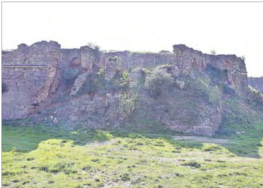
El baluard de Sant Andreu de la Ciutadella es troba en un estat visiblement degradat. GERARD BLANCHÉ
