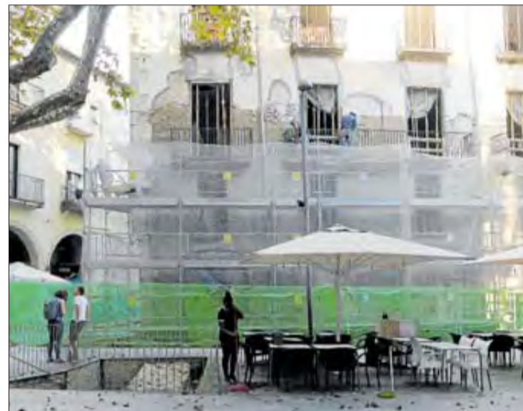
L'edifici en obres, a la plaça de les Patates. CONXI MOLONS
