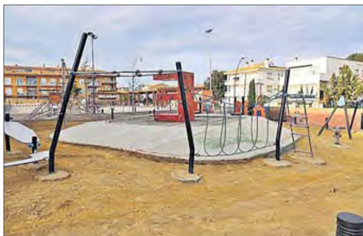
Es repararà el paviment i es repararan els jocs. BASILI GIRONÈS
