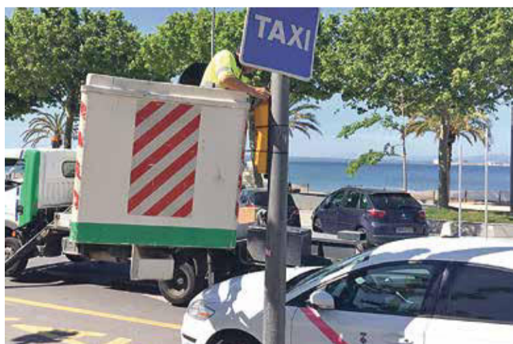
A LES PARADES DE TAXI. Instal·lacions per connectar les màquines d'ozó AJ DE ROSES
