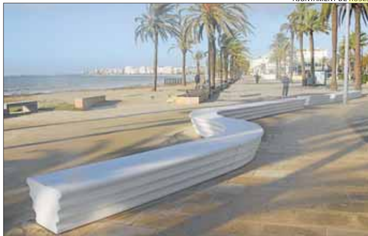
Els bancs són de formigó motllurat i presenten diferents volumetries.
