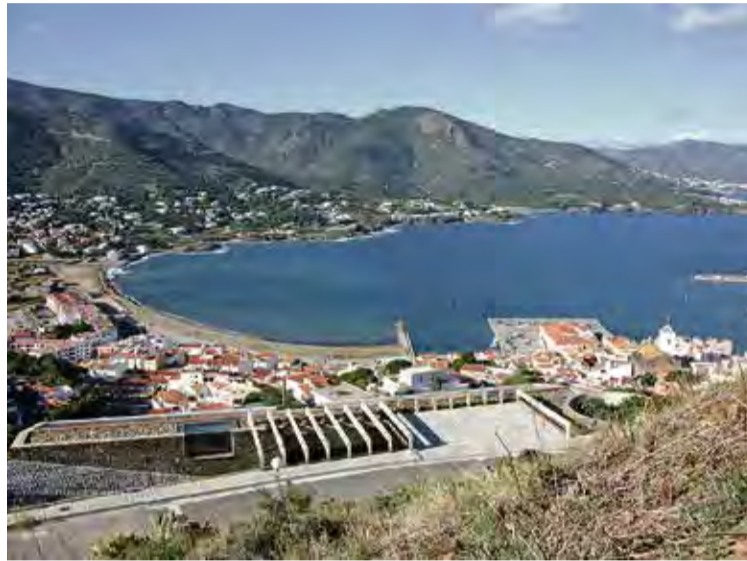
LA BADIA DEL PORT DE LA SELVA. Imatge des del dipòsit d'aigua municipal
