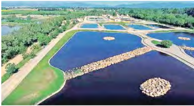
EMPURIABRAVA. La depuradora, biològica, tracta 16.750 m³ d'aigua al dia HORA NOVA
