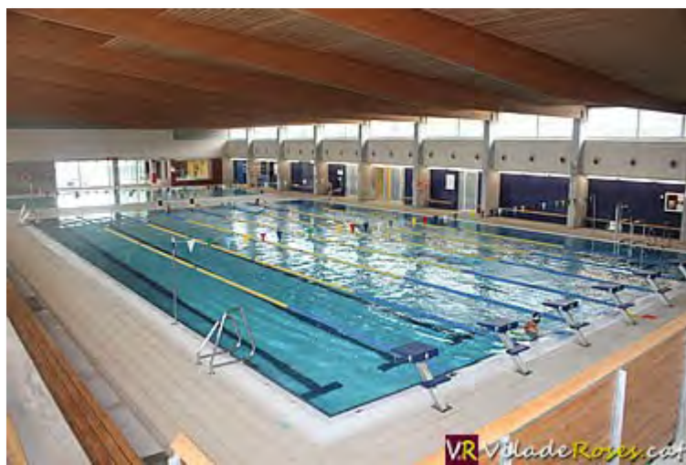
La instal·lació aquàtica de la Piscina Municipal de Roses
