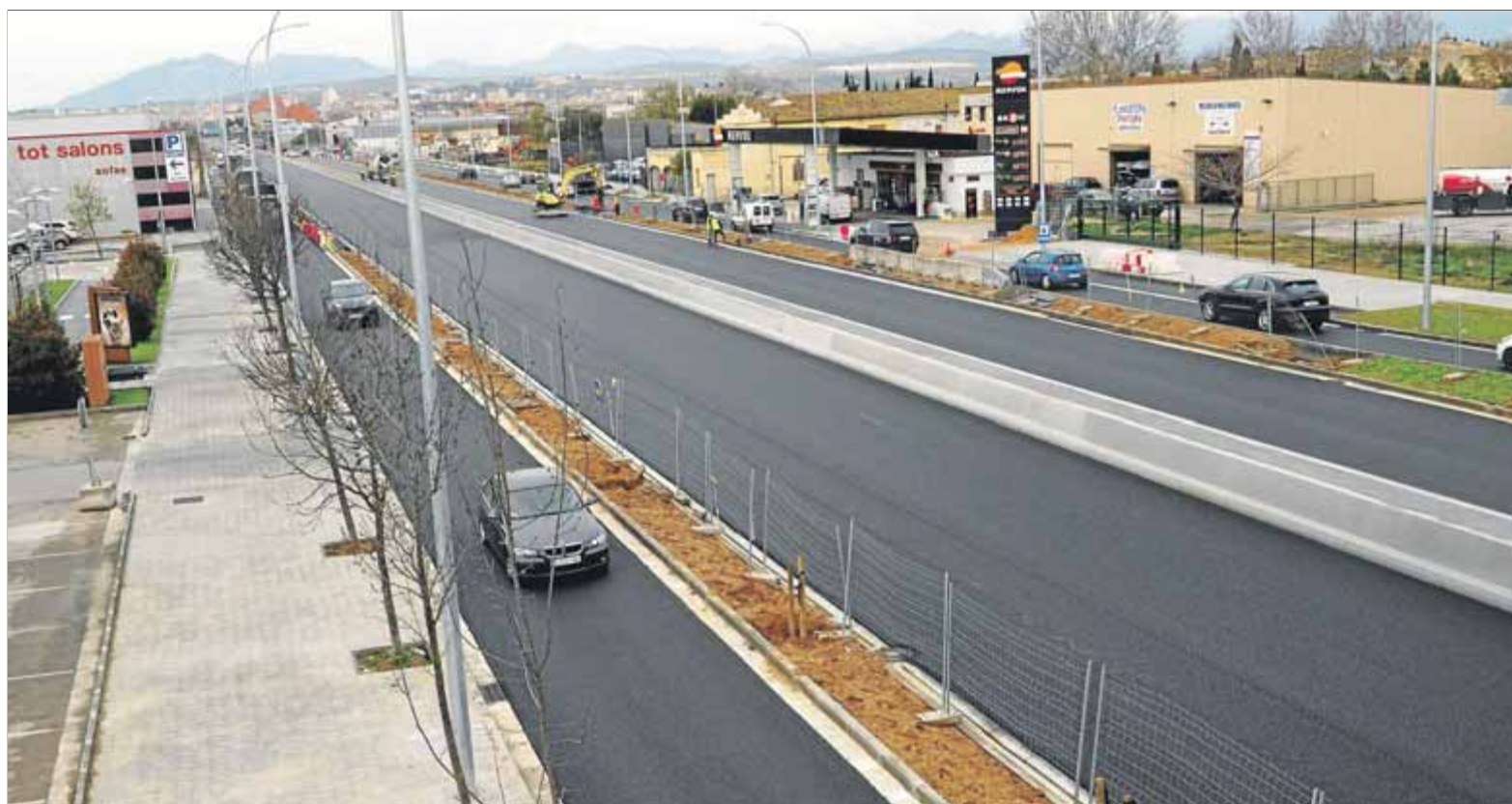
Els treballs d'asfaltatge ja semblaven acabats ahir al matí al tronc central i a les dues vies de servei ■ JOAN PUNTÍ
