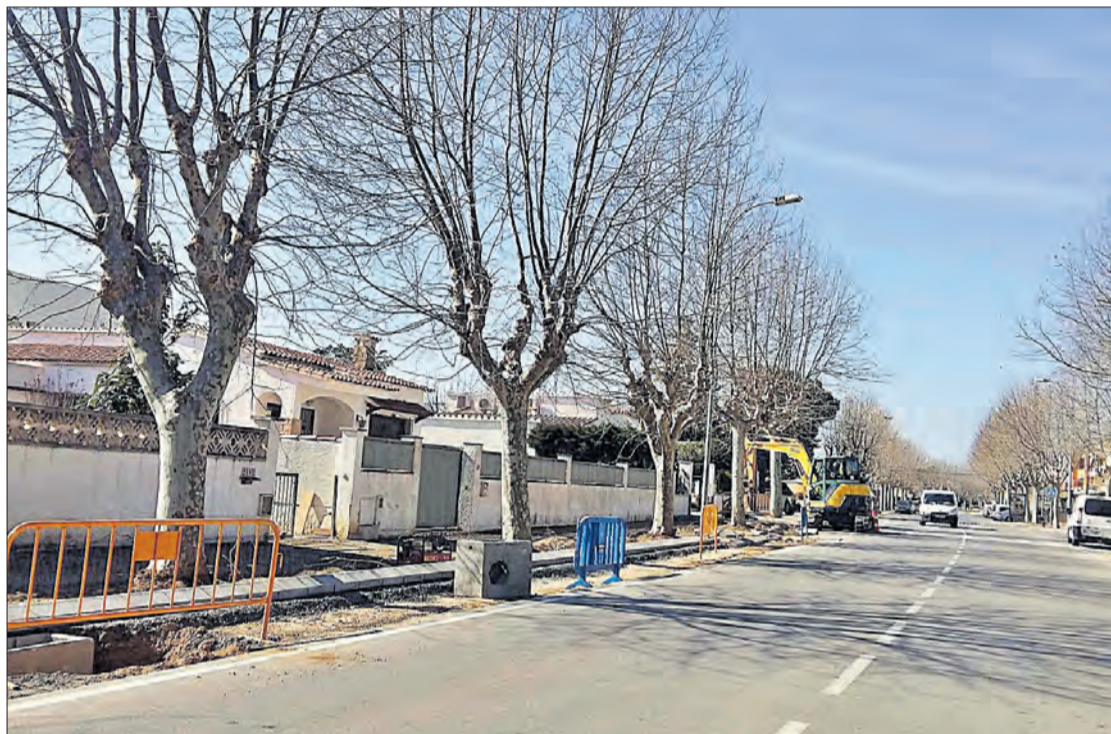
Les obres que s'estan portant a terme a l'avinguda Marinada. DIARI DE GIRONA
