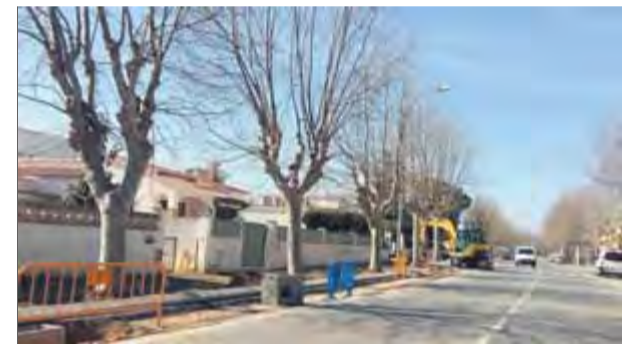
Els arbres de la via afecten la xarxa de serveis
