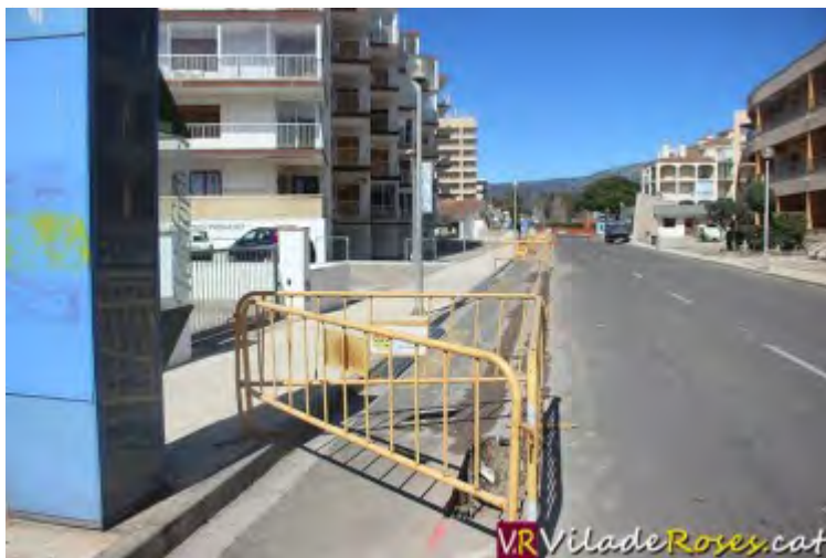
Al carrer Port Reig de Santa Margarida és un dels punts on s'instal·len les canonades de gas natural
