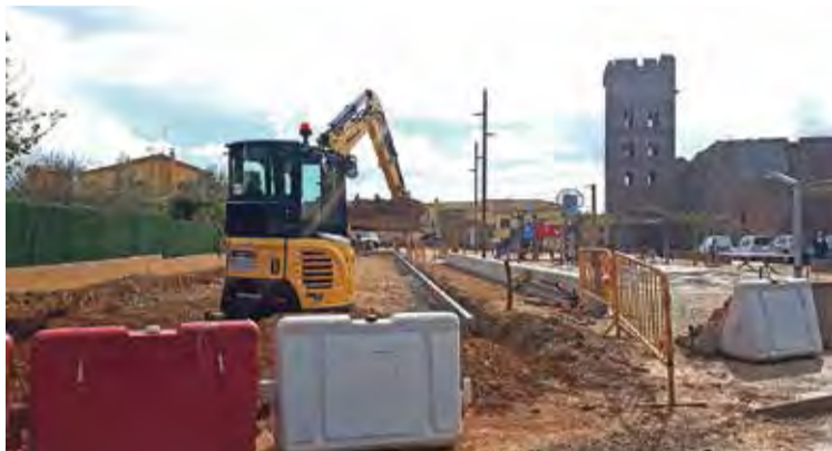
SANT MIQUEL. S'està construint un aparcament per prioritzar els vianants HORA NOVA
