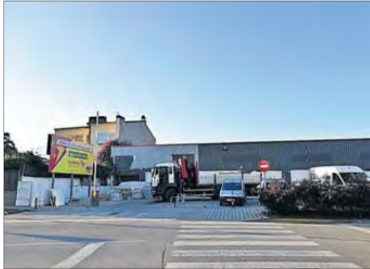
L'edifici, ja en obres, on s'instal·larà l'empresa. ANNA FONT
