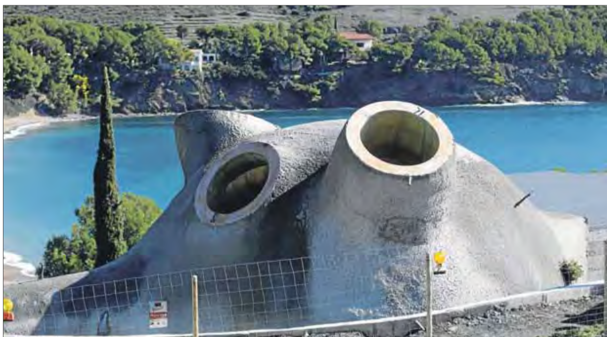
L'edifici singular que es construeix al lloc de l'antic restaurant El Bulli, en una imatge del passat mes de març ■ QUIM PUIG
