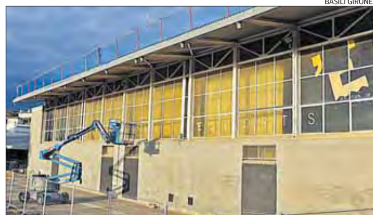
Les obres tenen una durada prevista de tres setmanes.
