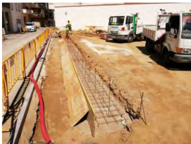
Les obres per la creació de la placeta EMPORDA.INFO
