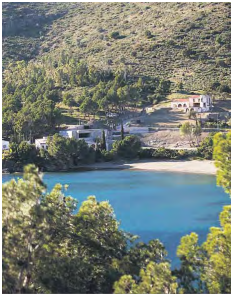
Les obres segueixen en curs a les instal·lacions de l'antic restaurant ■ QUIM PUIG
