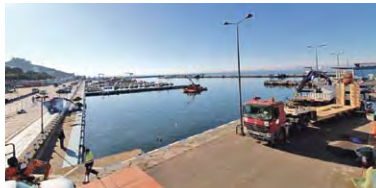
LES ACTUACIONS. Les obres de millora haurien de durar quatre mesos
