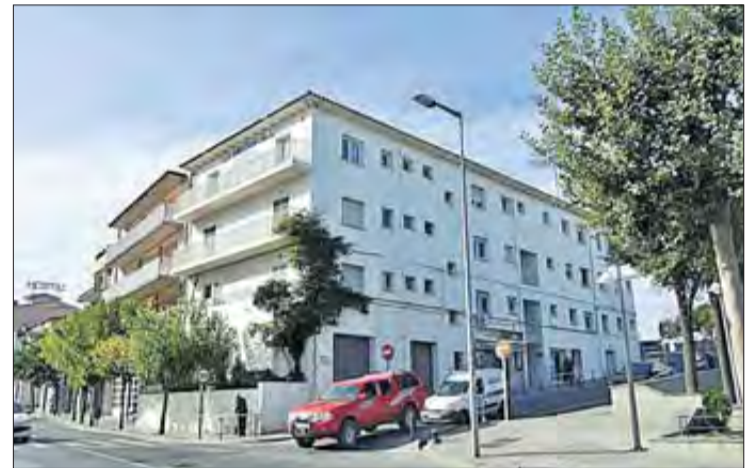
L'edifici de Can Masset, una part del qual s'ha d'enderrocar. AJ. DE L'ESCALA
