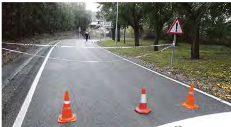
GI-5129. La carretera que uneix Vilafant amb Borrassà es va haver de tallar
