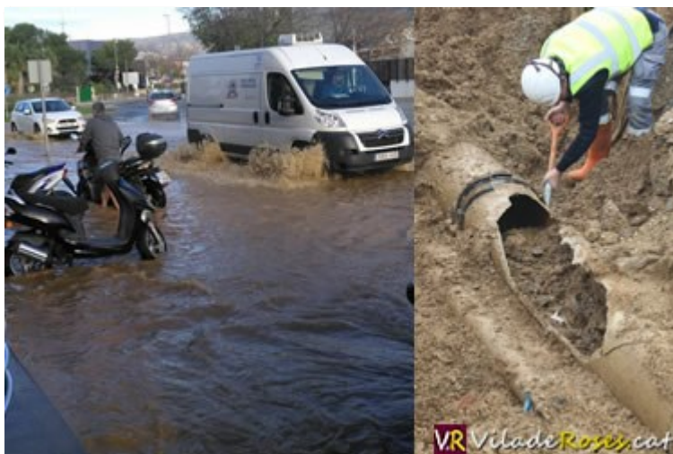
A l'esquerra, la Gran Vila plena d'aigua; i a la dreta, un operari reparant la canonada
